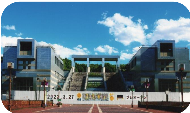
多摩中央公園通りをまたぐパルテノン大通り橋で表示看板に ブレオープンが 2022-3-27 とグランドオープン 2022-7 とある
