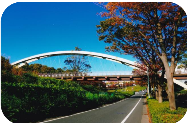
弓の橋；尾根幹線を跨ぐ多摩東公園と丘の上広場・さくら広場をつなぐ橋。
