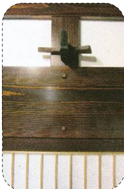
梁と柱を組む鼻栓と込み栓
