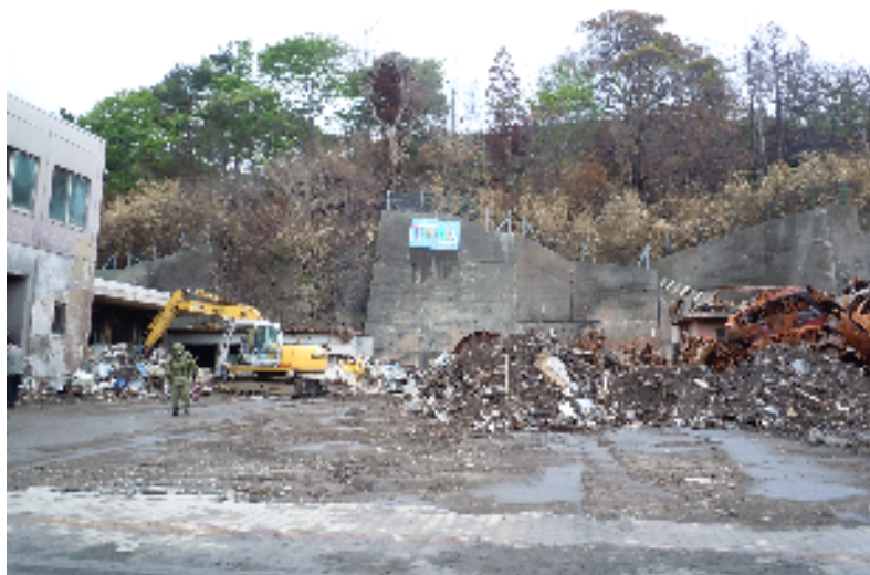
(作業中の自衛隊員の後方壁面には“復興支援ありがとう”との幕が掲げられている)
