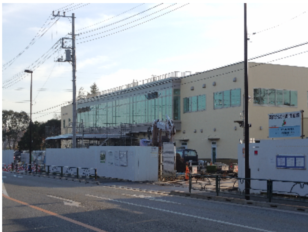
(道路側から眺める足場の外れた環境コミュニケーションセンター)
