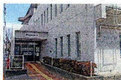
▲町田十層貯蓄物処理の分館（原町三）
